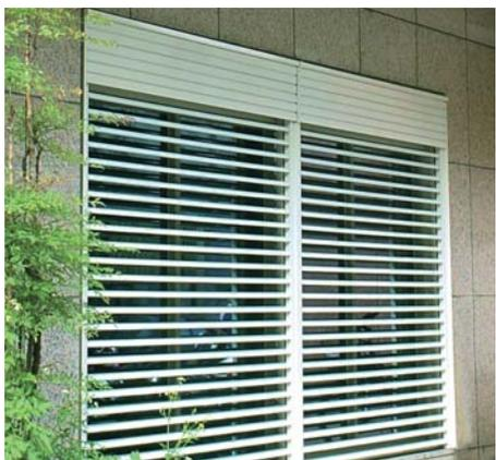
平掛式 (BUILT-IN) 裝在室外牆洞上，百葉收納箱朝外。
